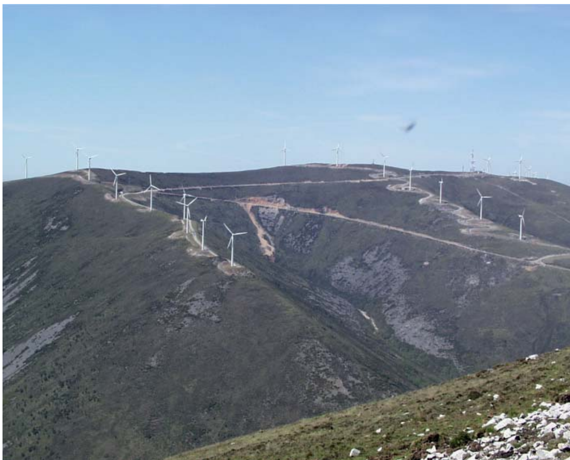
Figura 5. Vista general de la alteración del hábitat turbera de cobertor por la instalación de un parque eólico y sus infraestructuras de acceso.
