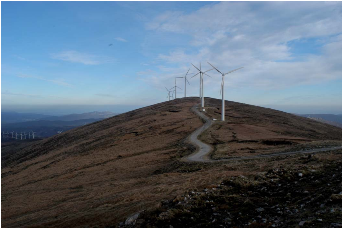
Figura 4. Infraestructura eólica instalada sobre turbera de cobertor en la sierra de O Xistral. — Wind farm installed on blanket bog in the mountains of O Xistral.
