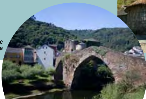
Puente sobre el río Navia
