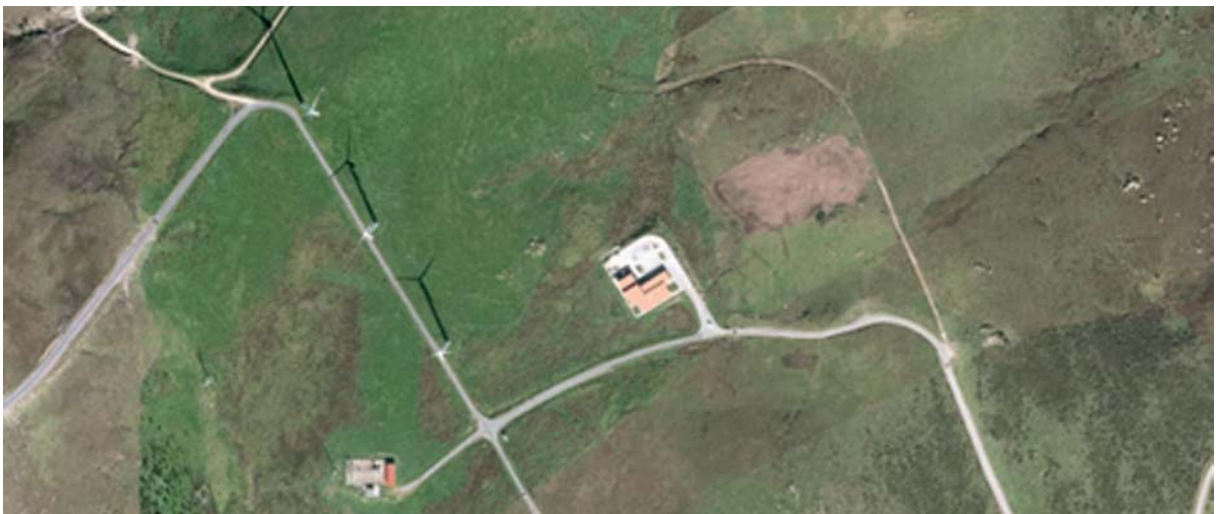
Figura 18- Tremeal do Chan da Cruz (ZEC Serra do Xistral). Turbeira de Cobertor cunha antigüidade de máis de 5.500 anos, destruída para a construción dun parque eólico. A central eléctrica, a liña de aerogeradores e os viais construíronse sobre a turbeira. Tras as obras a maior parte da superficie da mesma foi transformada nun pasteiro artificial (cor máis verde e homoxéneo da fotografía).
