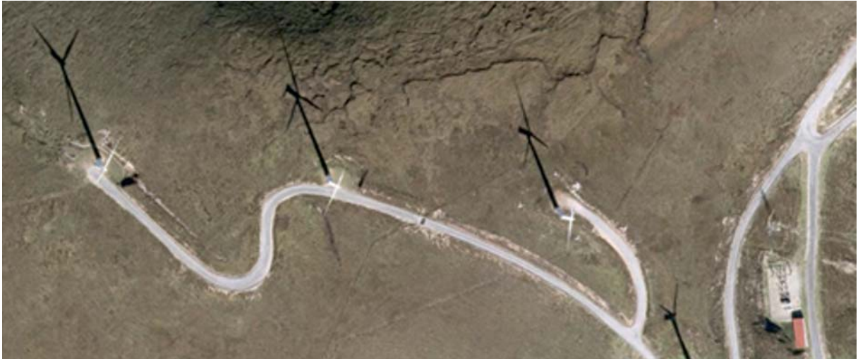
Figura 17- Alto de Onsolar (Valadouro). Liña de aerogeradores e central eléctrica emprazados sobre unha área cuminal cuberta por unha Turbera de cobertor (Nat-2000 7130*). ZEC Serra do Xistral. Zona Núcleo Reserva da Biosfera Terras do Miño.
