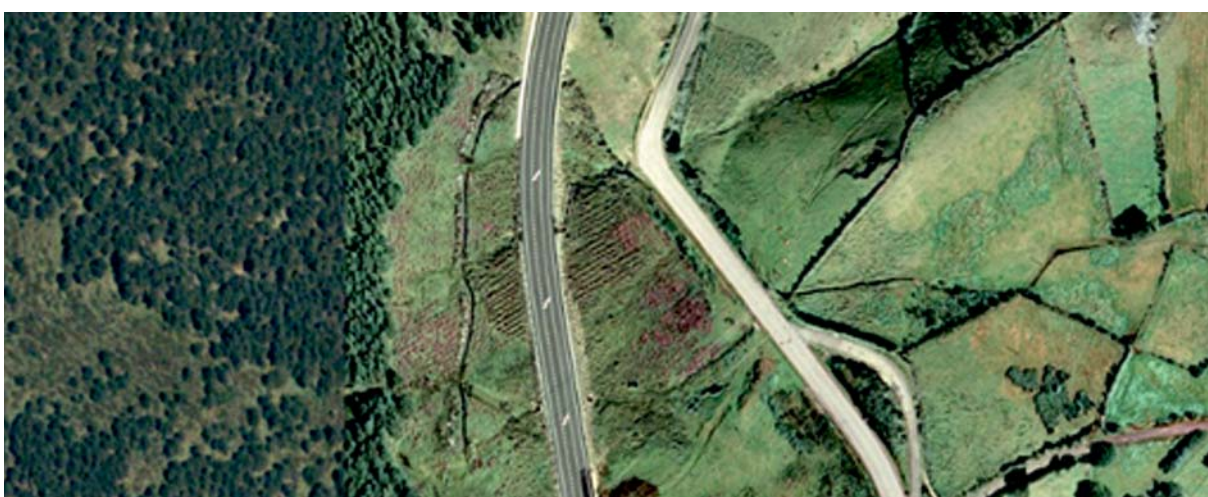
Figura 33- Detalle de imaxe anterior (PNOA-2014). Na imaxe recoñécese a gabia realizada para desviar as augas da turbeira no transcurso das obras.
