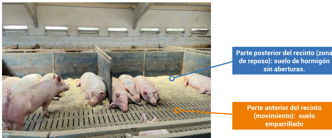
Figura 5. Superficie de suelo mixto en cuadra de gestación confirmada.
