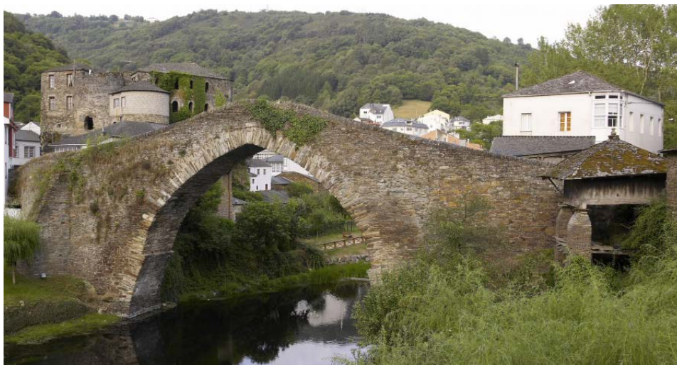
Figura 5.2. Ponte sobre o río Navia, en Navia de Suarna, construído no século XIV. Fotografía: Turgalicia.
