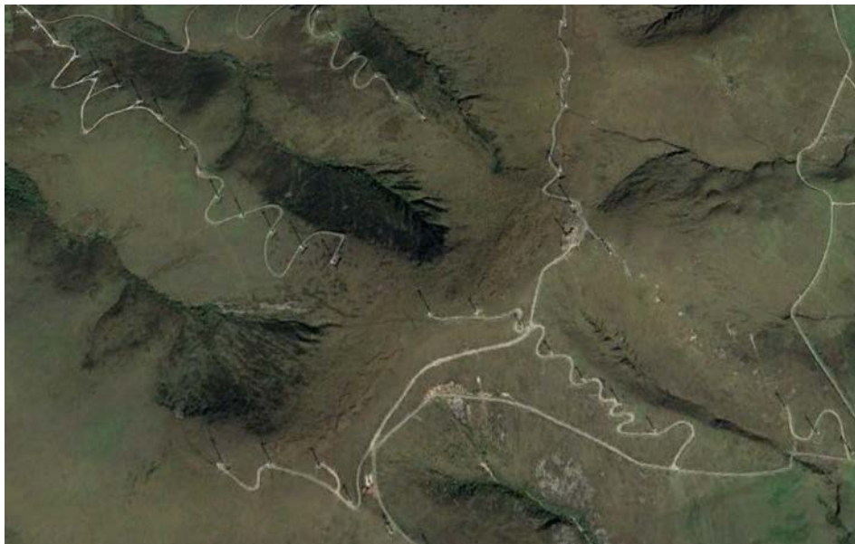
Figura 5.13. Fotografía aérea da Serra do Xistral (Zona núcleo da Reserva da Biosfera Terras do Miño), onde se construíron distintos parques eólicos sobre humidais de montaña (Turbeiras de cobertor activas, Queirogais húmidos, Turbeiras altas activas, etc).
